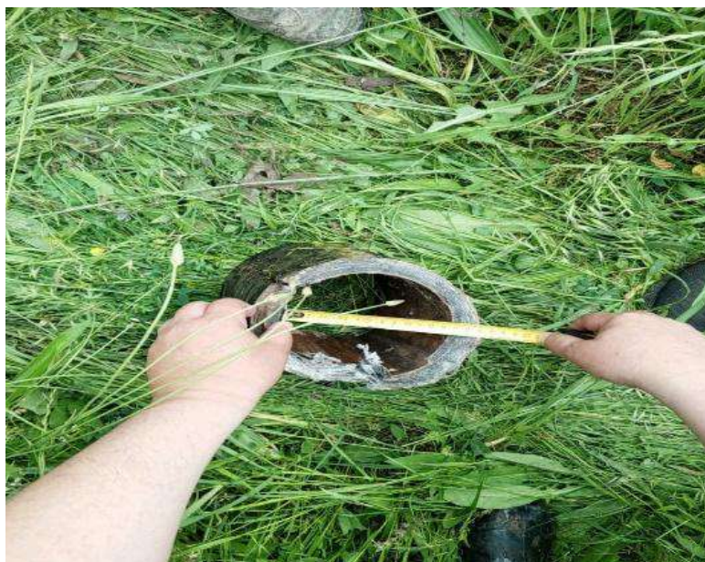
Рис.1.3. Отклонение расположения диаметров, образовались асимметричные окружности.
